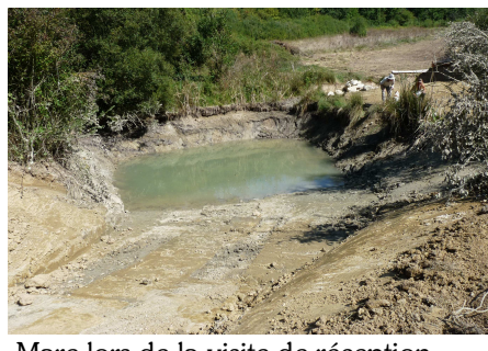
Mare lors de la visite de réception des travaux en septembre 2010, après le curage
